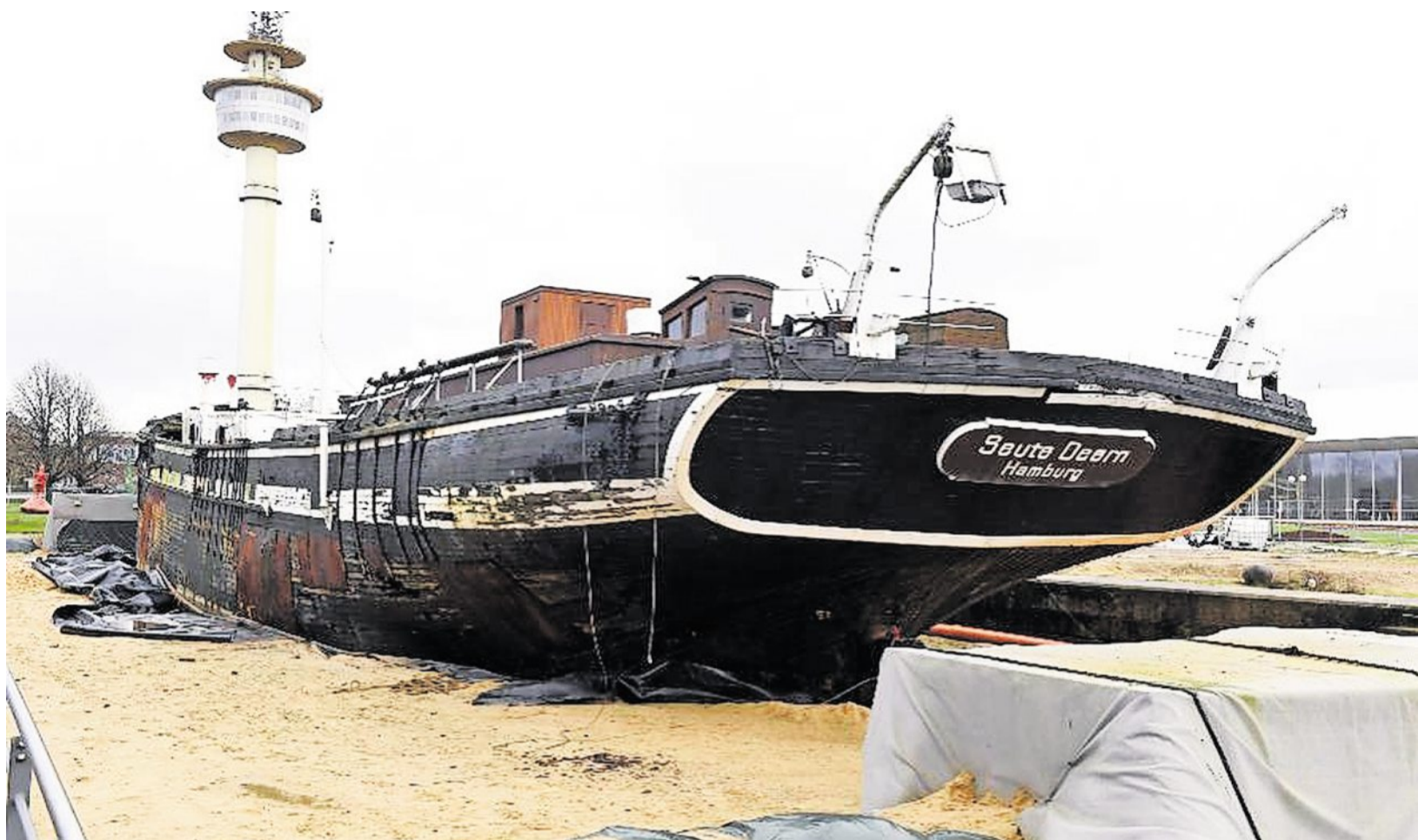
Zuerst kommt der giftige Lack ab. Nach der Schadstoffbeseitigung erfolgt das richtige Abwracken der „Seuten Deern“, für die Arbeiten liegt das einstmalige schmucke Schiff an der Baltimore-Pier in Bremerhaven. Foto: Scheer
