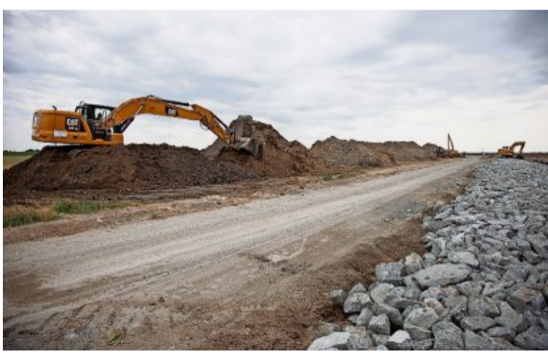
Die Bagger rollen in Rintzeln. Für insgesamt rund 3,45 Millionen Euro wird der Uferabschnitt nördlich von Wremen sicherer gemacht.
