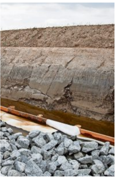
Mit einem kleinen Notdeich wird die Baustelle während der Arbeiten vor dem Wasser geschützt.
