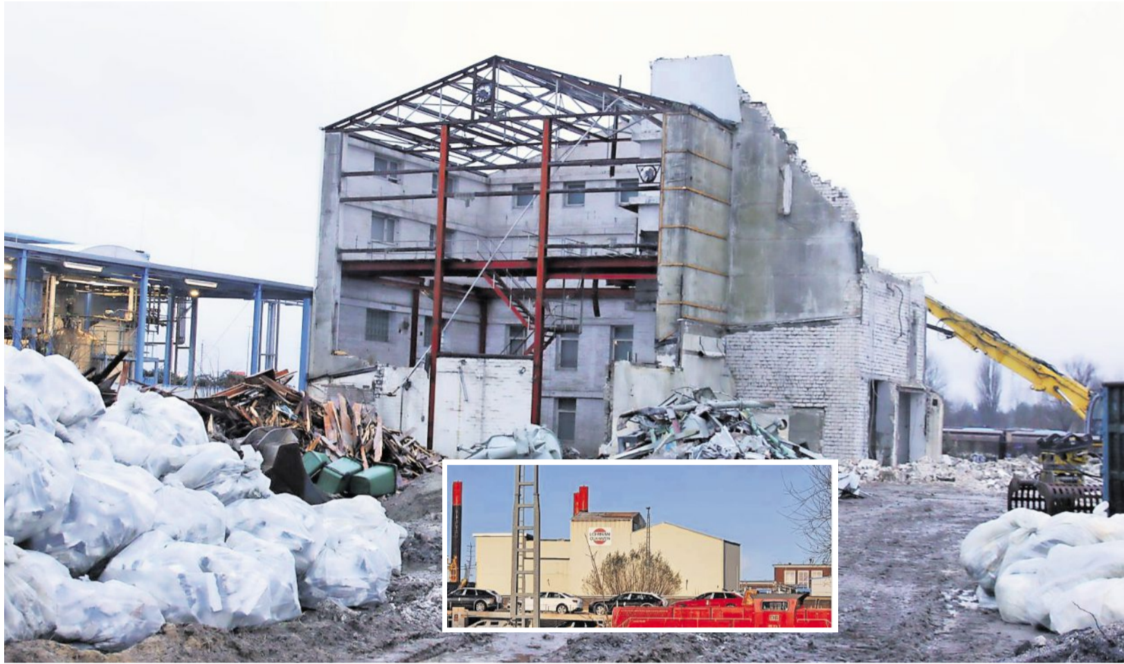
Nur der letzte Teil des einstigen Gebäudekomplexes (kl. Foto) steht noch. Bis Jahresende wird das 4000 Quadratmeter große Grundstück im Fischereihafen an der Neufelder Straße freigeräumt sein. Fotos: Sassen/red
