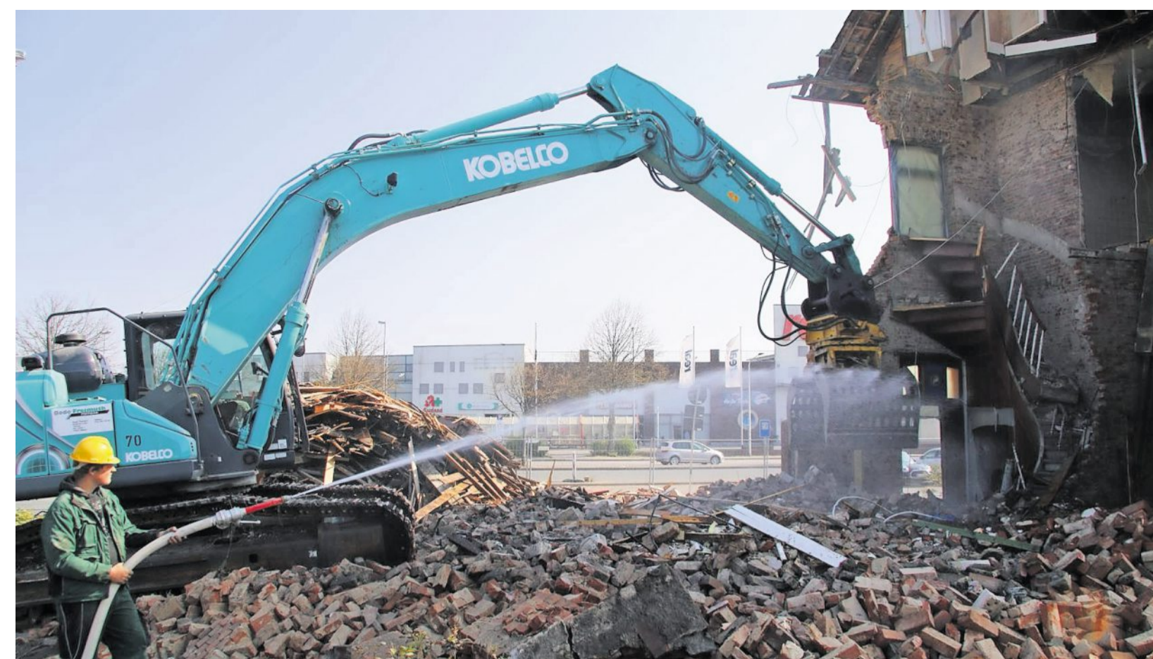
Um die Staubbildung beim Bahnhof möglichst gering zu halten, spritzt ein Bauarbeiter mit einem Schlauch Wasser auf die Stellen, in die sich der Abrissbagger Stück für Stück hineinfrißt. In der nächsten Woche wird der alte Bahnhof Geschichte sein. Im Zuge des ZOB-Neubaus wird dort eine Insel für die Busse des Linien- und Fernverkehrs entstehen. Fotos: Potschka
